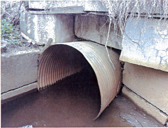
Photo 29 : Fosse composée de bloc de béton en aval du ponceau
