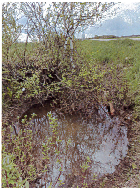
Photo 19 : Entrée enfouie à 50%
