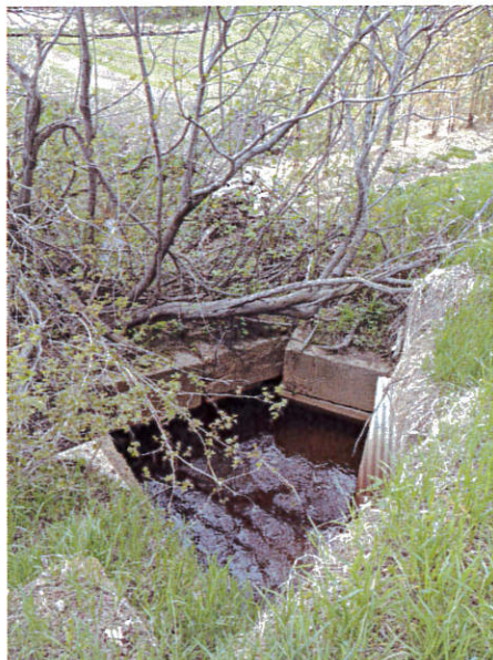
Photo 23 : Fosse composée de bloc de béton en amont du ponceau
