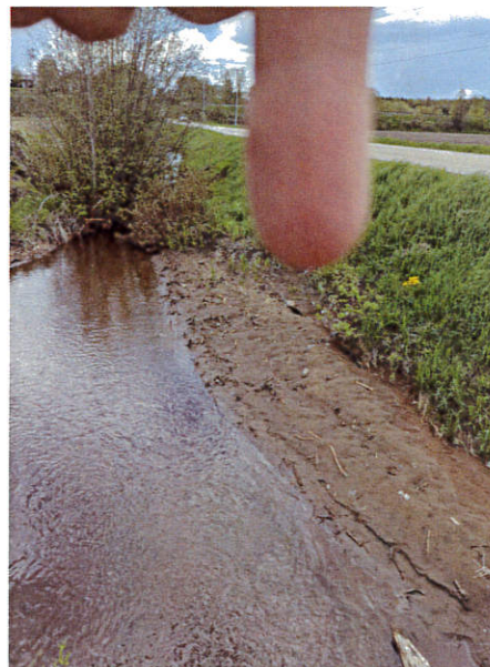
Photo 20 : Sortie complètement enfouie
