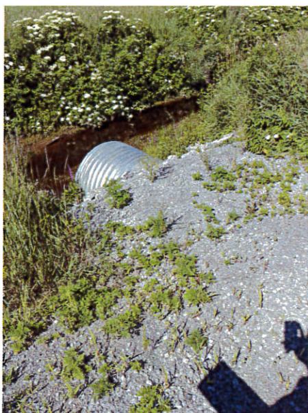
Photo 12 : Extrémité côté ouest
