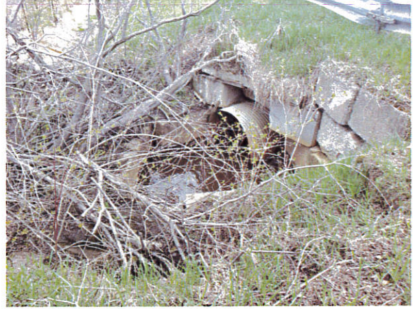
Photo 30 : Fosse composée de bloc de béton en aval du ponceau
