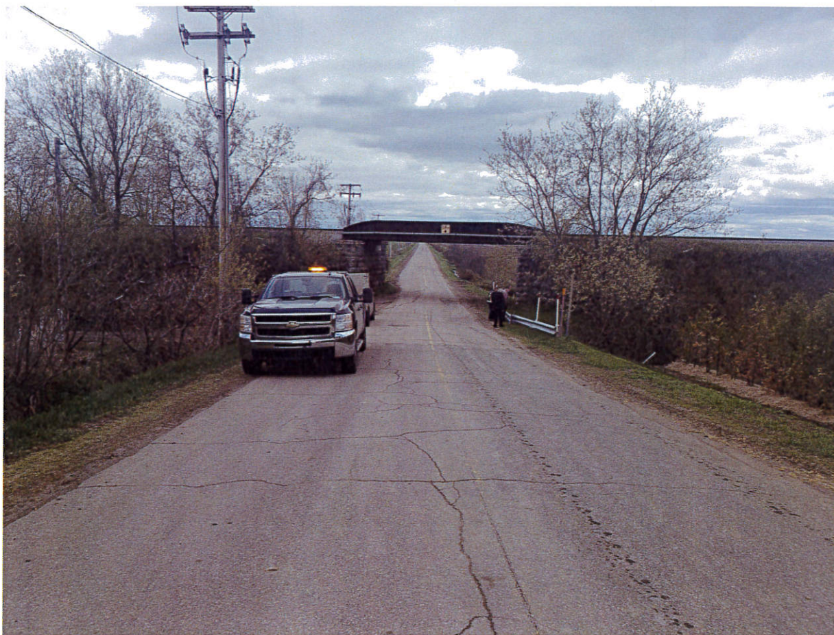
Photo 4 : Chaînage 2+420 – Pont du chemin de fer (Qc/Gatineau)
